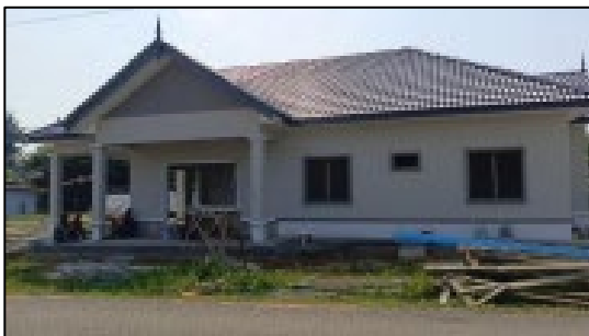
Rajah 1: Pembinaan Rumah Mesra Rakvat (SPNB)
