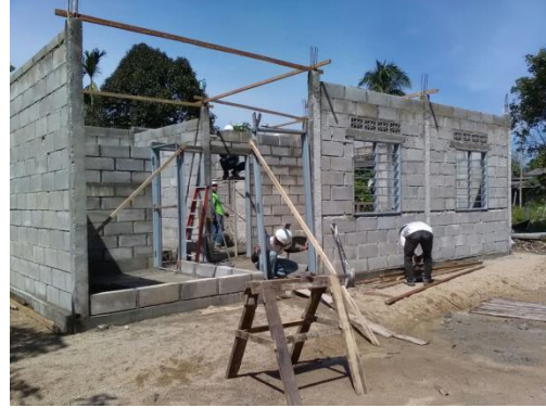
Foto 4: Kerja-kerja pembinaan sedang dijalankan
